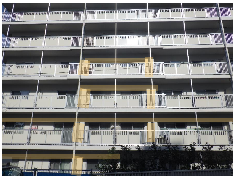
ピタコラムフレーム工法(B棟)
