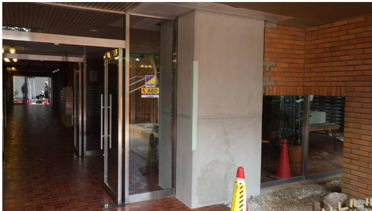
エントランス柱 タイル下地完了
