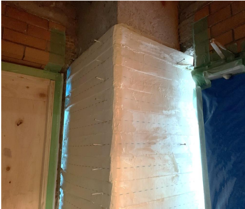
ベルト巻き付け完了
