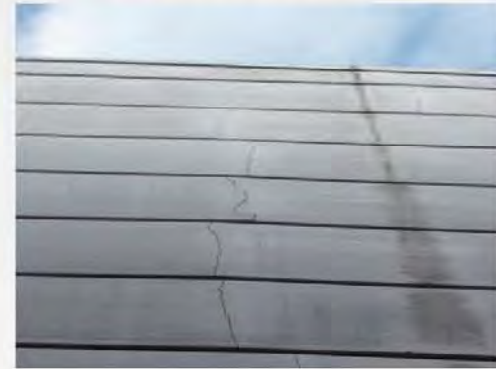
3 外壁で複数の仕上材にまた がったひび割れ・欠損等
