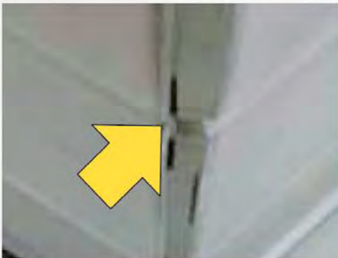
5 シーリング材の破断等
