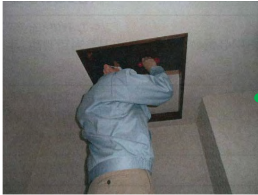
天井等の雨漏りの跡
