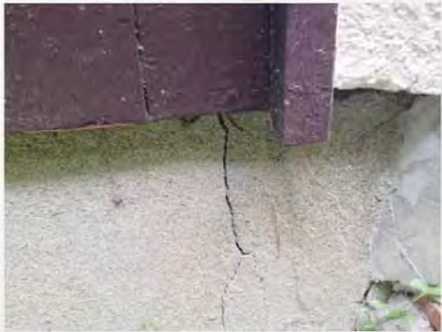
1 基礎のクラック (幅0.5mm以上のひび割れ)
