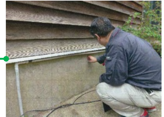
基礎のクラック、外壁の欠損等
