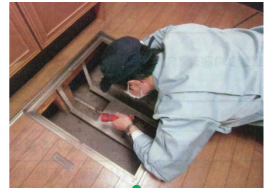
土台のひび割れ、劣化
