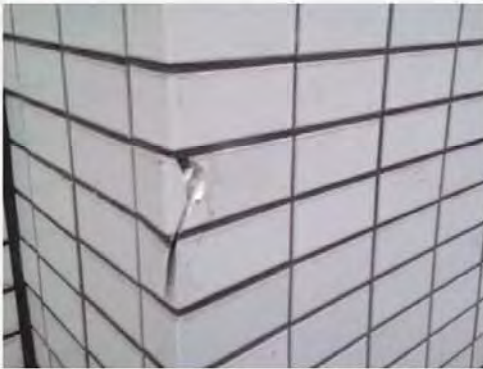
2 外壁で下地材まで到達する ひび割れ・欠損等
