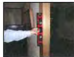
水平器による柱の傾きの計測
