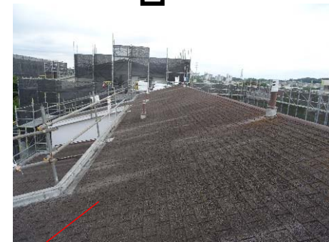
改修前 シングル屋根
