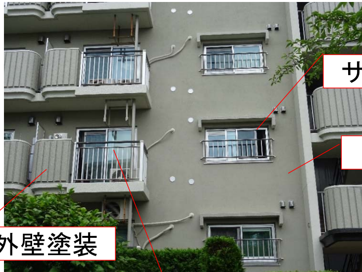
手摺横バー不良部のみ取り換え
