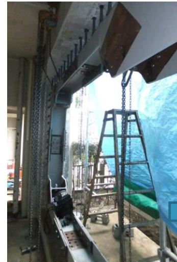
高力ボルトで接合する
