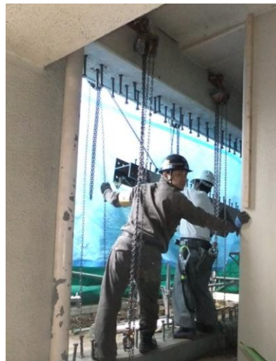
パーツを吊り上げながら設置
