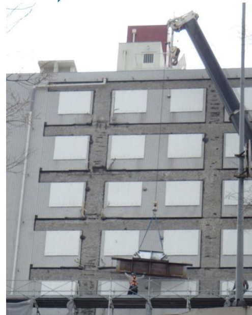
クレーンで吊り上げ、建物と足場の隙間に鉄骨を入れる
