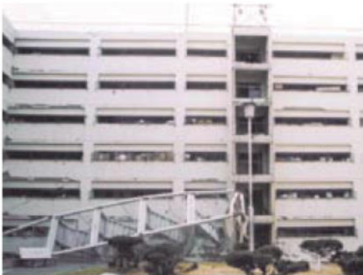
阪神淡路大震災での被害状況 鉄骨階段が転倒
