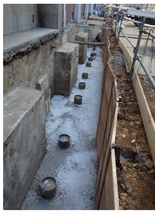
掘りおえたところ 既存の建物の基礎 をむき出しにする
