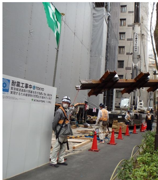
クレーンで吊り上げ、建物と足場の隙間に鉄骨を入れる
