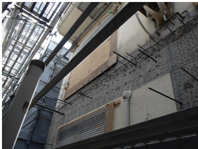
バルコニーを撤去した状態
