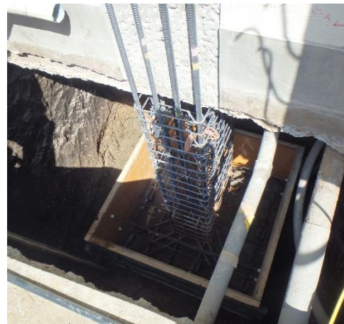
新基礎と新柱の鉄筋
