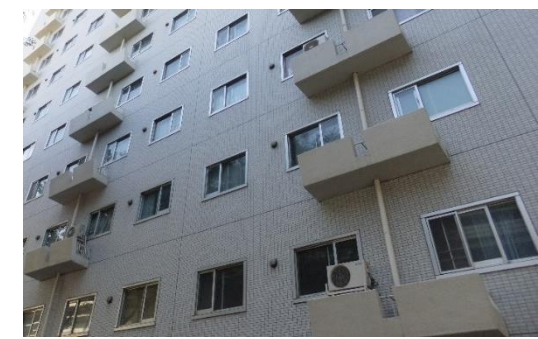
室外機置場床のところに新しい梁フレームをつくる
