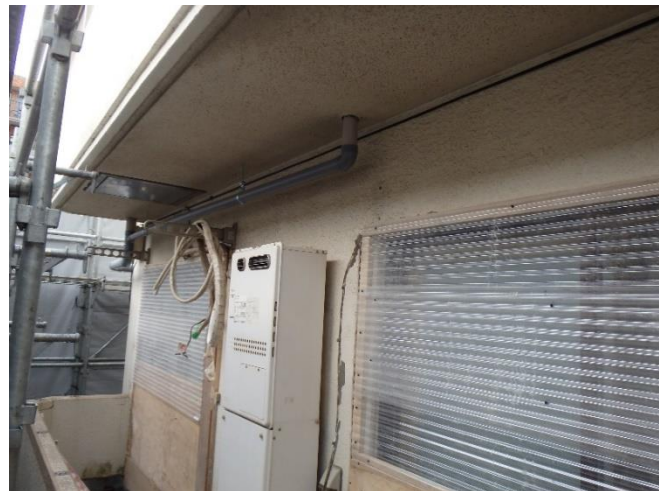
窓に光が入るよう上は透明、 下はベニヤ板で養生
