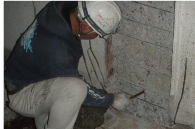
躯体に穴をあけカプセルを挿入
