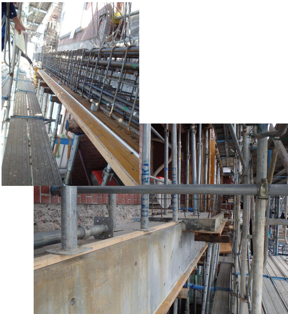
型枠を支えるサポートが林立する
