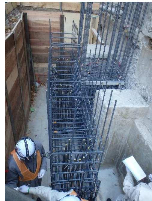
新しい基礎の鉄筋
