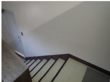
劣化調査写真
