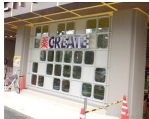
鉄骨パネル補強 (ISGW)
