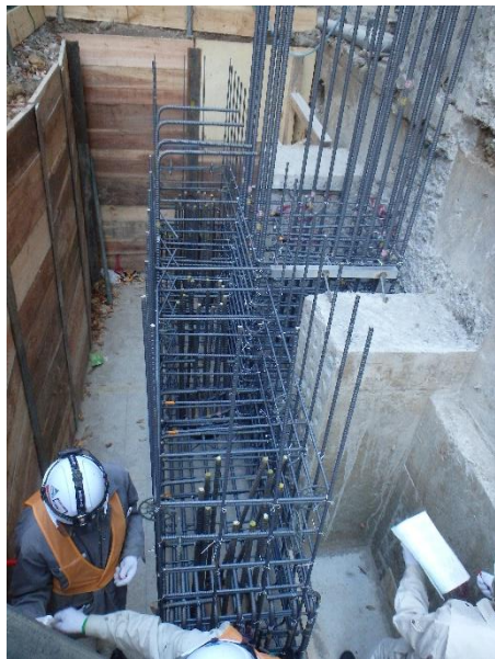
新しい基礎の鉄筋
