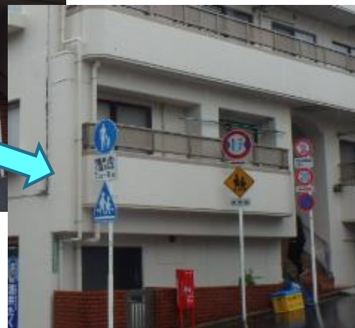
RCフレーム補強
