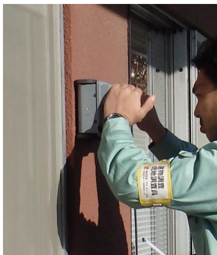
レーダーで鉄筋の間隔、本数を確認
