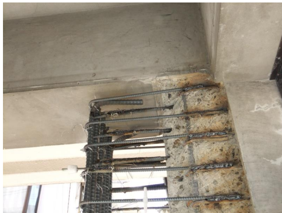
新しい鉄筋を既存の鉄筋に溶接
