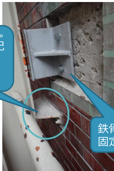
鉄骨階段固定補強の例
