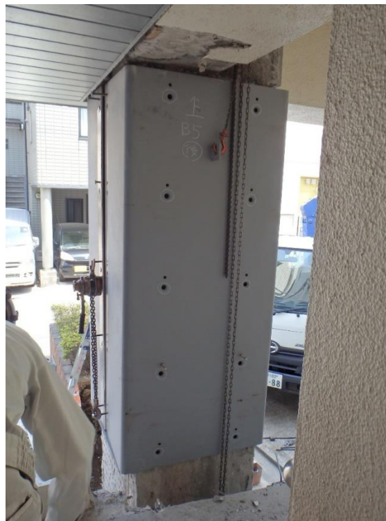
鋼板巻き立て補強 コンクリート巻き立て補強
