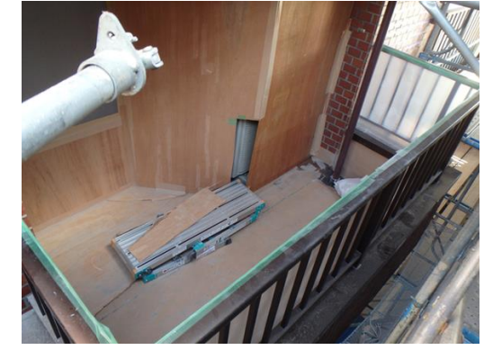
バルコニー床のところに新しい梁フレームをつくる
