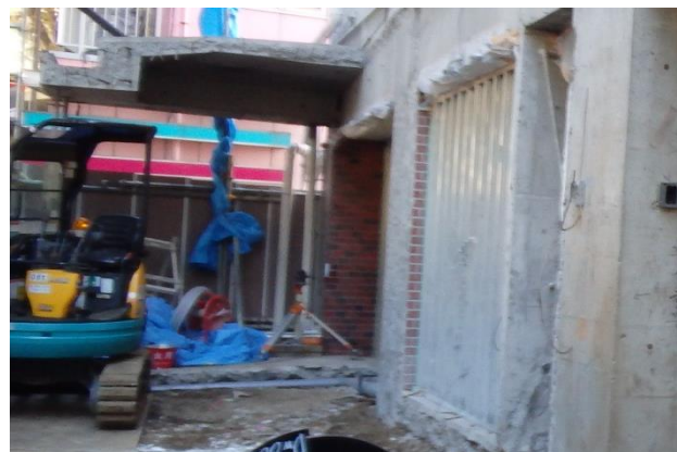
ロビーを解体
