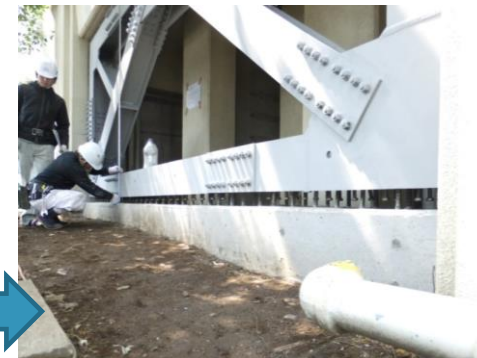
ブレース設置後、周辺にモルタルを充填する。
