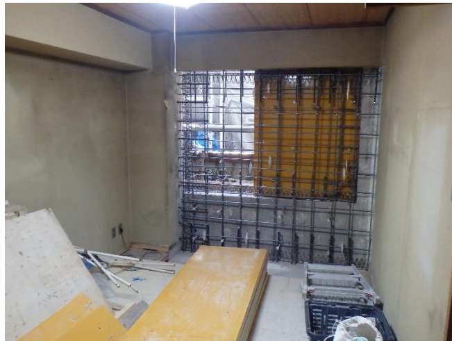
室内での工事の様子 (窓撤去の上、増し打ちするところ)
