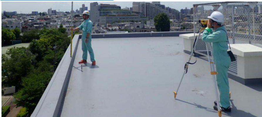
屋上にて高低測量を行い不同沈下を調べる
