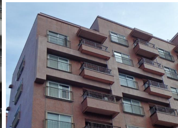
RCフレーム補強
