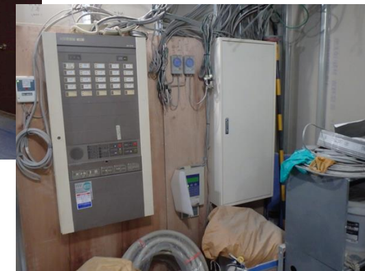
仮設の分電盤・警報設 備置場
