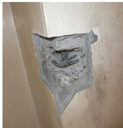
柱のコンクリートをはつり、内部の鉄筋の形状、径を確認
