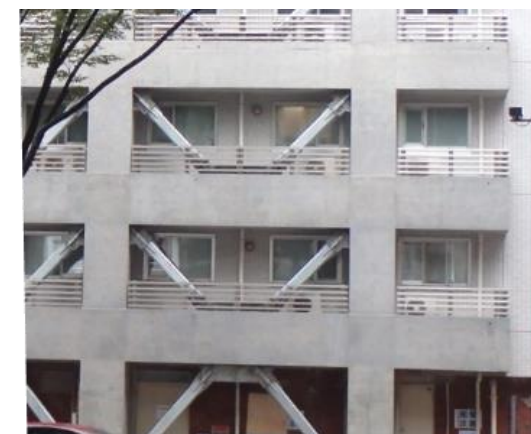
SRCフレーム + 鉄骨ブレース
