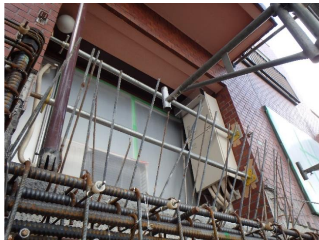
バルコニーを撤去した状態。プラベコで養生
