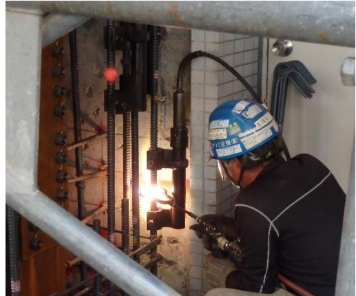
縦の鉄筋の溶接
