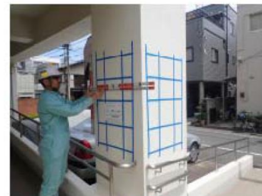
レーザー探査した鉄筋の位置をテープで記しているところ
