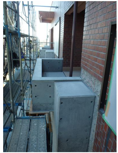
コンクリート打設
