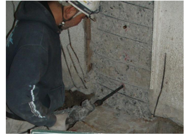
ハンマードリルでアンカーボルトを打つ
