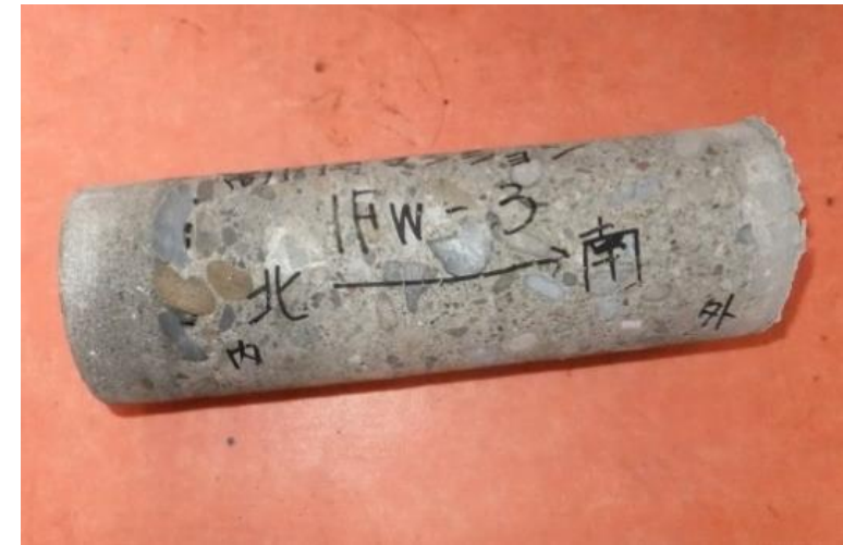
壁を貫通させて壁の厚みを確認
