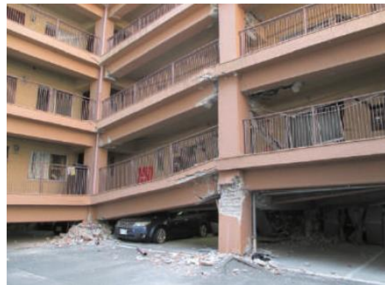
落階 熊本地震・阪神淡路大震災での被害状況
