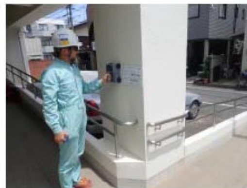
レーザー探査した鉄筋の位置をテープで記しているところ
