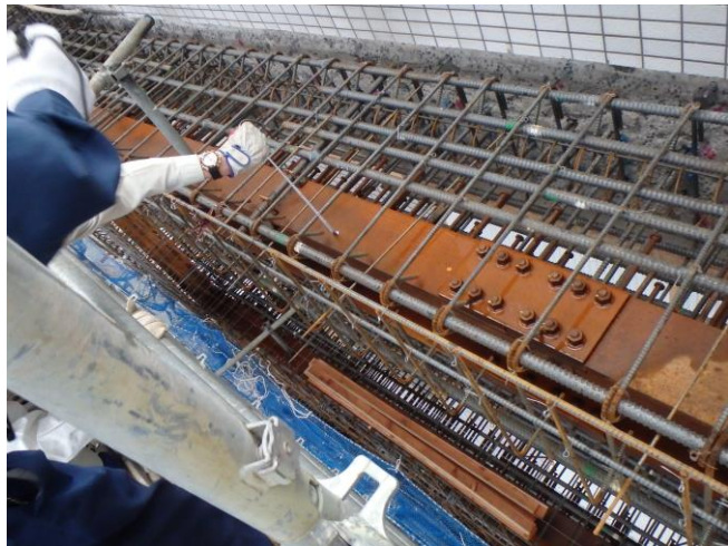
SRCの梁フレーム
