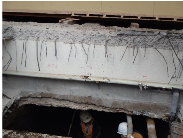
バルコニーの下を掘削
