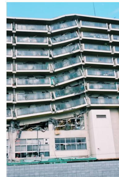
落階 熊本地震・阪神淡路大震災での被害状況
