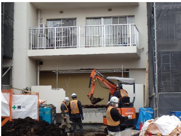
1階（管理室）のバルコニー 解体
