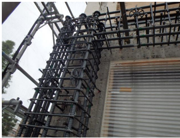
RCの柱と梁フレームのところ
