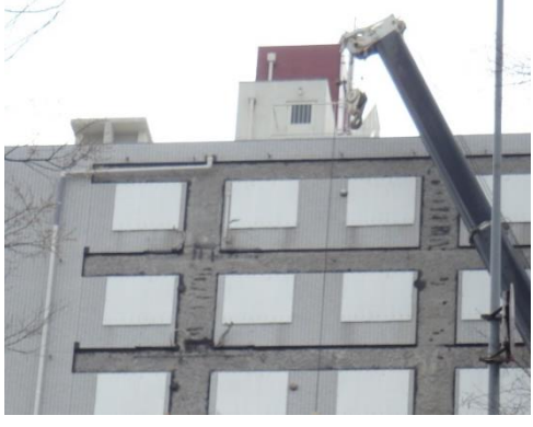
タイルやモルタル撤去
