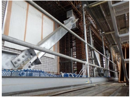
鉄骨・鉄筋を組み
