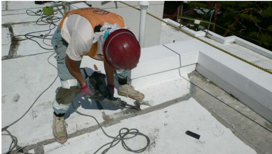
既存シポテックス防水層撤去+押えコンクリート補修
