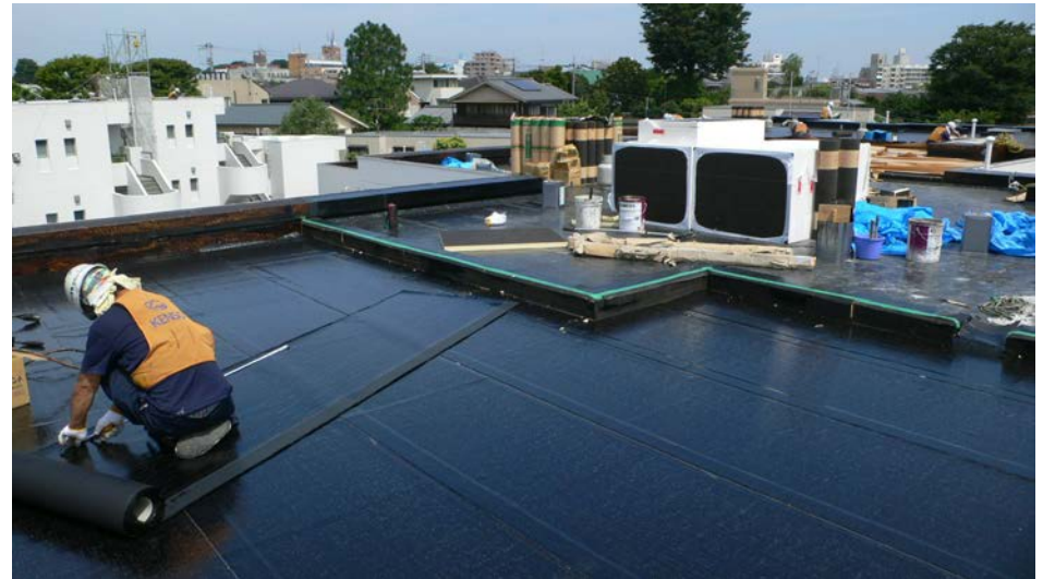
断熱材t=50mm+改質アスファルト防水トーチ工法
