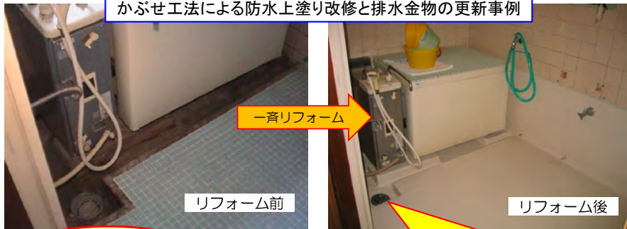
かぶせ工法による防水上塗り改修と排水金物の更新事例
