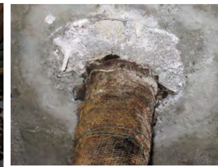
写真 排水トラップ直下の貫通部を階下より見上げると、エフロレンセスが見られる。
