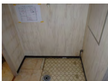
【洗濯機取外し】
