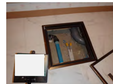
【将来配管 床点検口】
