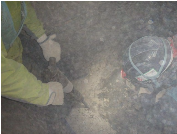
【浴室 解体・ハツリ状況】
