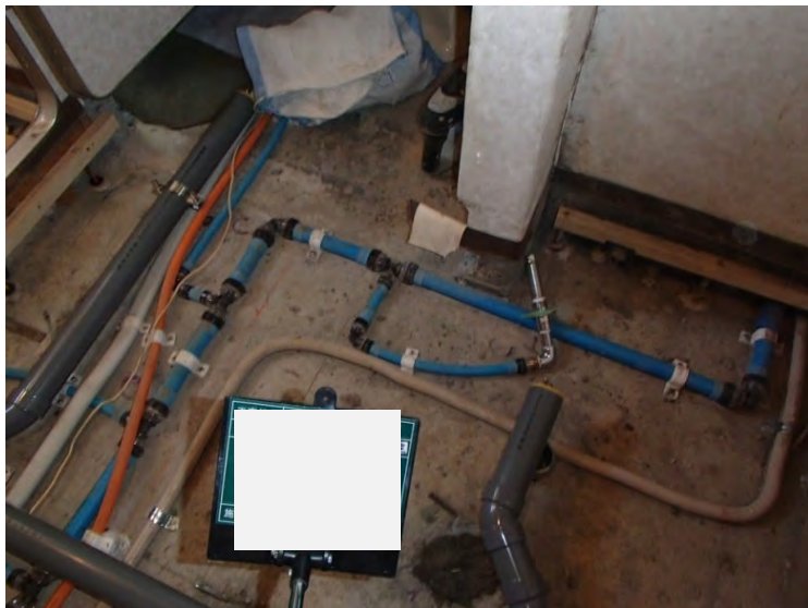
【浴室 床上配管】
