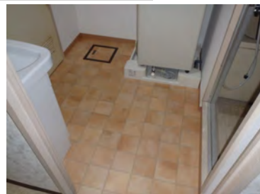
【洗面所仕上げ】
