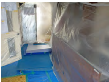
【室内養生 台所】
