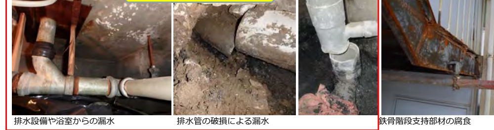
排水設備や浴室からの漏水 排水管の破損による漏水 鉄骨階段支持部材の腐食
