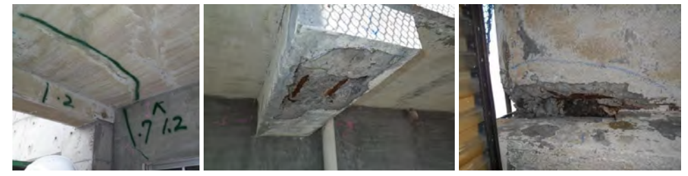
コンクリート躯体のひび割れや中性化 鉄筋の腐食、爆裂 コンクリートの剥落、欠損
