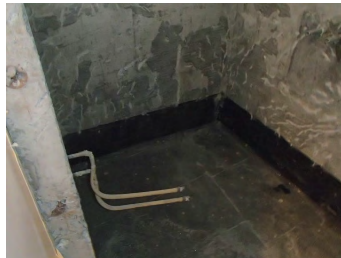
【浴室 解体・ハツリ（壁面・床面すべて撤去）】
