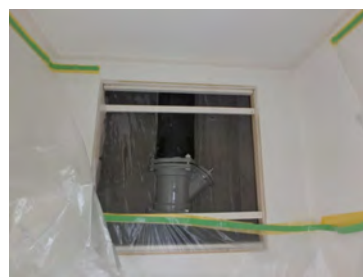
【同左 立て管との接続解除】
