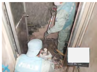
【浴室 ガラ搬出状況】
