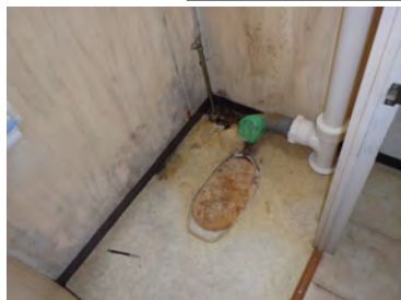
【大便器取外し】
