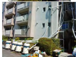
【浴室 粉塵排気装置（排気ダクト・集塵機）】
