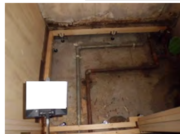
【トイレ床解体】
