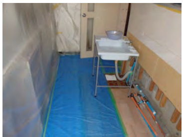
【室内養生 簡易流し台】
