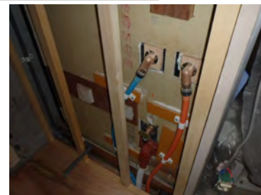
【洗面所壁配管】
