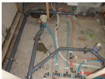
【洗面所床配管】
