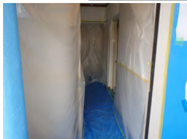
【室内養生 廊下】
