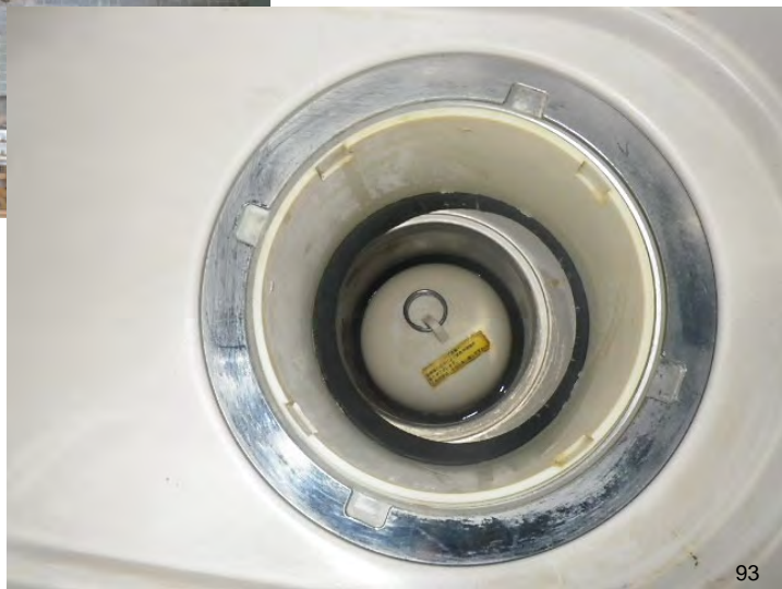
床かさ上げリフォーム事例 手首が入らず、手でワンが取れなくなった
