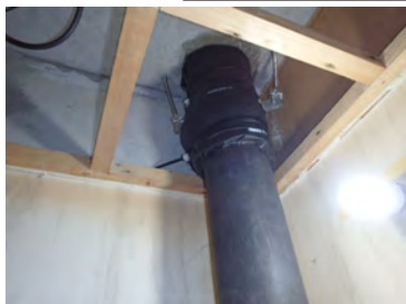
【トイレ立配管】
