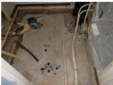
【洗面所床解体】
