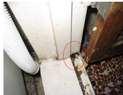
写真 朽ちて穴が開いている木製框から階下へ漏水した
