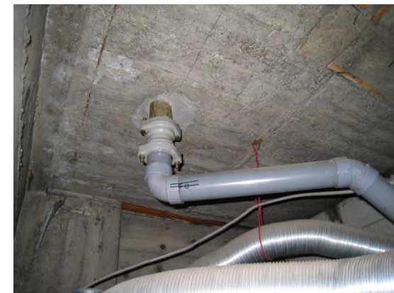
写真 防水層貫通部を残し、スラブ下端から排水管を更新
