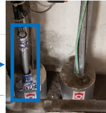
引込管 (8m, 鋼管ボルト)
