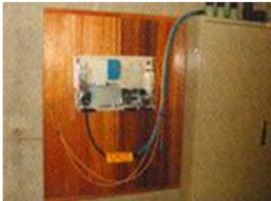
集合型回線終端装置
