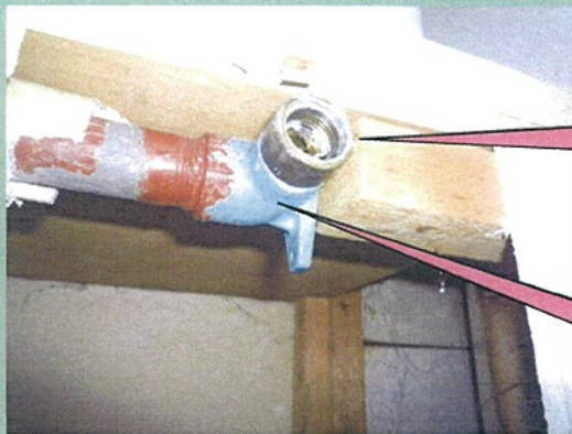
② 水栓取外し、壁開口
