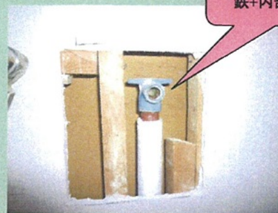
①② 水栓取外し、壁開口
