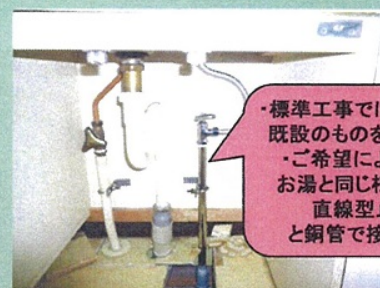
④ 給水配管の更新
