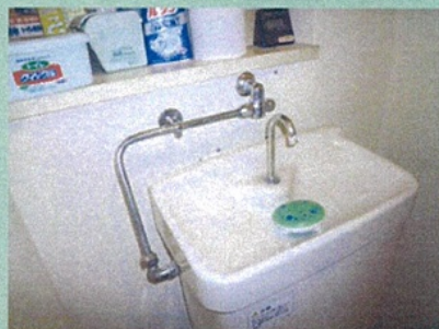
⑤、⑥ 壁・クロス下地の復旧 大便器水栓の仮復旧
