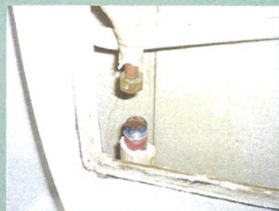
② 既存ソケットと銅管の取外し
