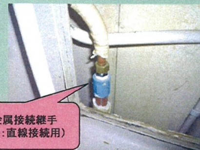
③、④ 給水継手の更新
