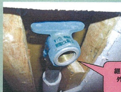
④ 異種金属継手による更新
