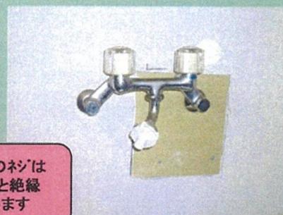
⑥ 洗濯機水栓の仮復旧
