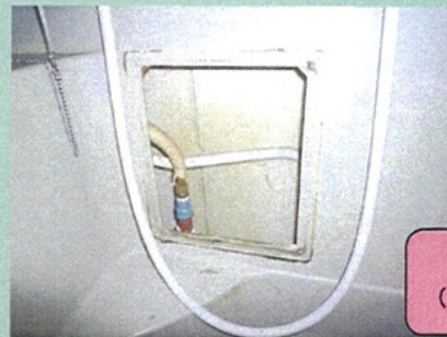
① 点検口の取外し
