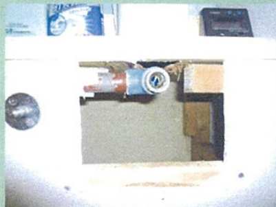
② 水栓取外し、壁開口
