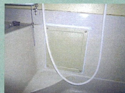
⑥ 点検口パッキン交換 周囲のシーリング
