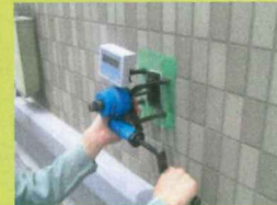
タイル引張り試験
