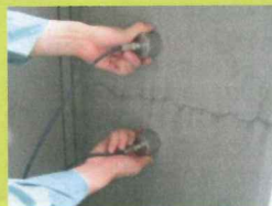
ひびわれ深さ調査
