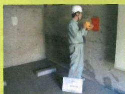
コンクリート強度試験
