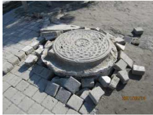
写真 2-3-1 液状化によるマンホールの浮上（出典：浦安震災アーカイブ）
