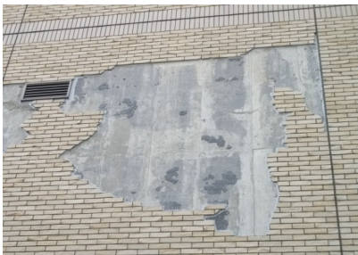
写真7 躯体コンクリートにひび割れがなくタイル 仕上げに浮きが生じた
