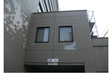
写真6 躯体コンクリートと張付 モルタル界面で剥離
