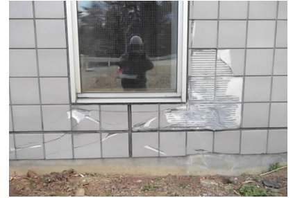
写真3 地盤変形(沈下)に伴う せん断ひび割れ およびタイル裏足での欠損
