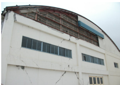
写真10 上部ラスシートモルタルの脱落下部 RC壁のせん断ひび割れ
