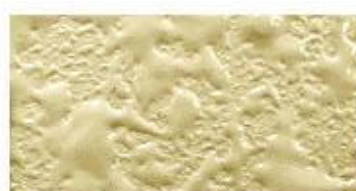
吹付けタイル(吹き放し)
