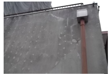
写真9 モルタル塗仕上げ浮きの 注入補修痕(被害なし) 被害はなかった
