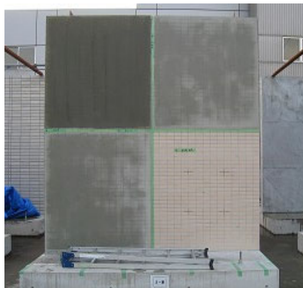
ネット伏せ込みとアンカーピン施工
