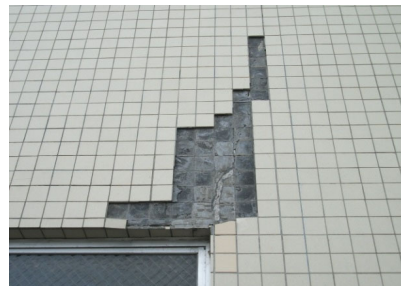
写真8 開口部周辺せん断ひび割れ(タイル は安全確保のため叩き落とし)
