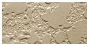
吹付けタイル(凸部処理仕上げ)
