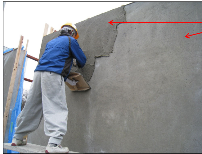
下地モルタルの施工
