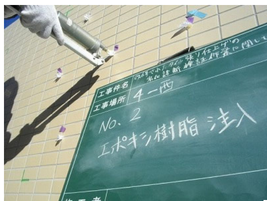
浮き部にエポキシ注入
