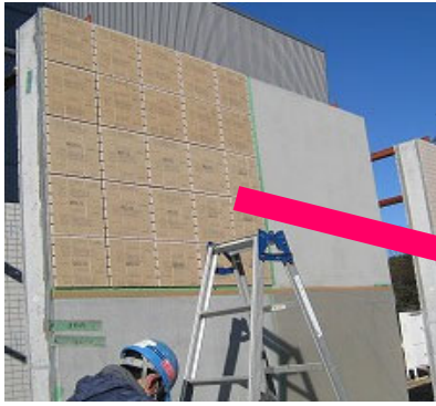
タイルonタイル施工
