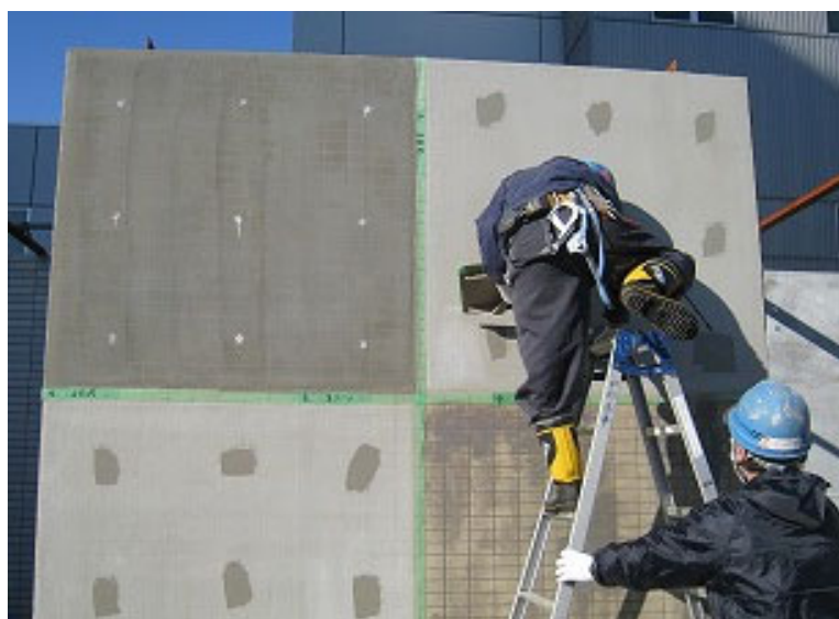
アンカーピン施工後
