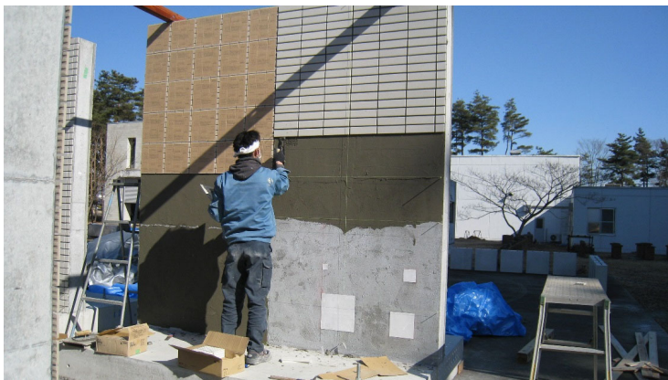
「モルタル張り」張付けモルタルの施工
