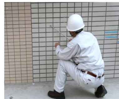
打診検査の状況
