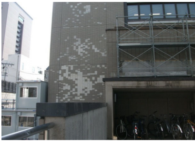
写真4 浮いたタイルを叩き落とし後の壁面
