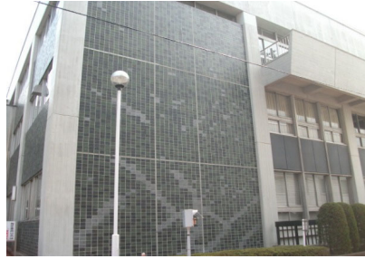
写真2 タイル仕上げひび割れ補修後
