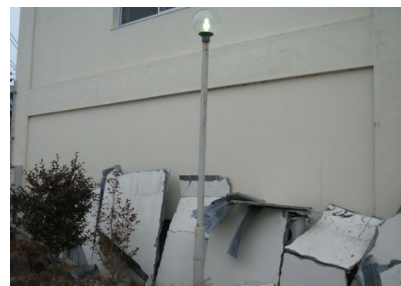
写真11 脱落したラスシートモルタル
