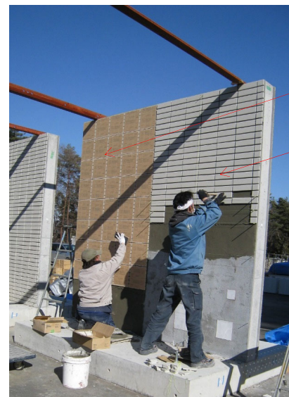
「モルタル張り」 タイルの施工
