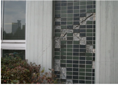
写真1 せん断ひび割れ上のタイルを 叩き落とし(補修前)
