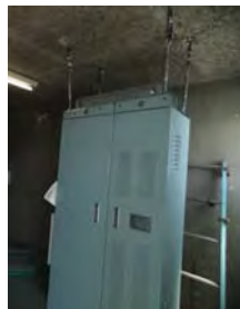
制御盤の振止め
