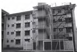
階段の支持を兼ねてテンションロッドを用いた構造形式とすることで軽快な外観となっている。
