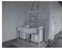
4 仮設洗濯機を設置した事例 夜8時になるとタイマーで電 源が切れる。使用上のルール も書いてある
