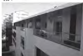
階段室型住棟を廊下型に改修し、エレベーターを設置。
