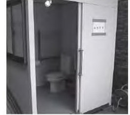
2 車椅子が使用できる大きさの 仮設トイレを設置した事例
