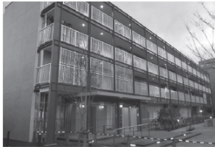
階段室型共用住宅を片側下型にリノベーションしエレベーターと片側廊下を新設した事例 コージャハイム千歳島山 11号棟 (リノベーション 東京都住宅供給公社)
