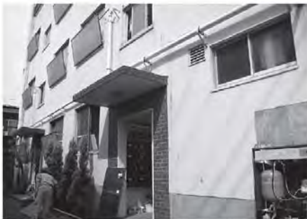
補強前（階段室出入口口廻り）
