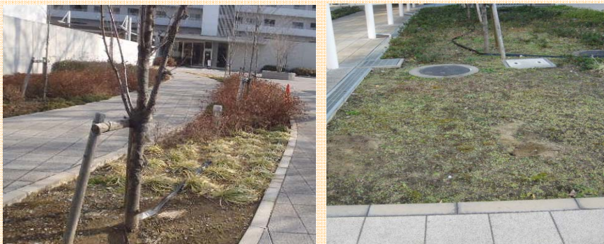
【エントランス外構、中庭 植替え前】
