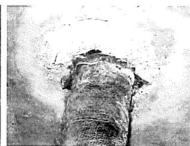
写真 排水トラップ直下の貫通部を階下より見上げると、エプロレッセンスが見られる。
